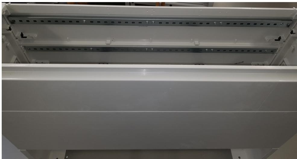
*Figura 4-7 montaggio dei binari con profilo C*
