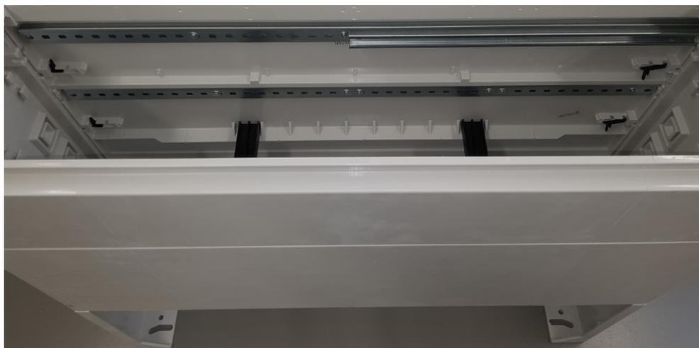
*Figura 4-8 montaggio dei binari con profilo C (posizionamento cavi)*
